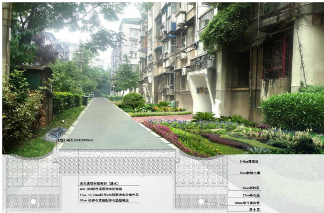
图 8.5.4 (1) -2 透水铺装及两侧植草沟实景图 (二)
