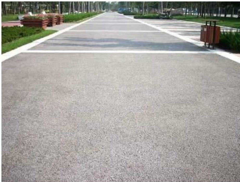
图 8.5.1 (1) -3 透水铺装实景图
