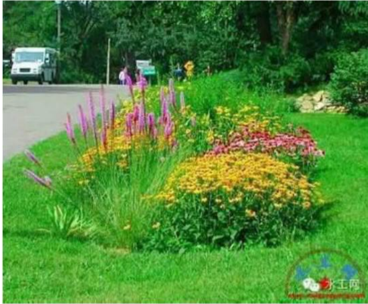
图 8.5.1 (3) -4 生物滞留设施实景图
